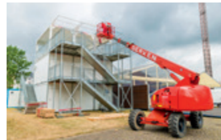
▼ Auch die Medien setzen auf Raumsysteme von Gerken: Aus der VIP-Lounge hoch über den Kirmesbesuchern berichtet center.tv.
